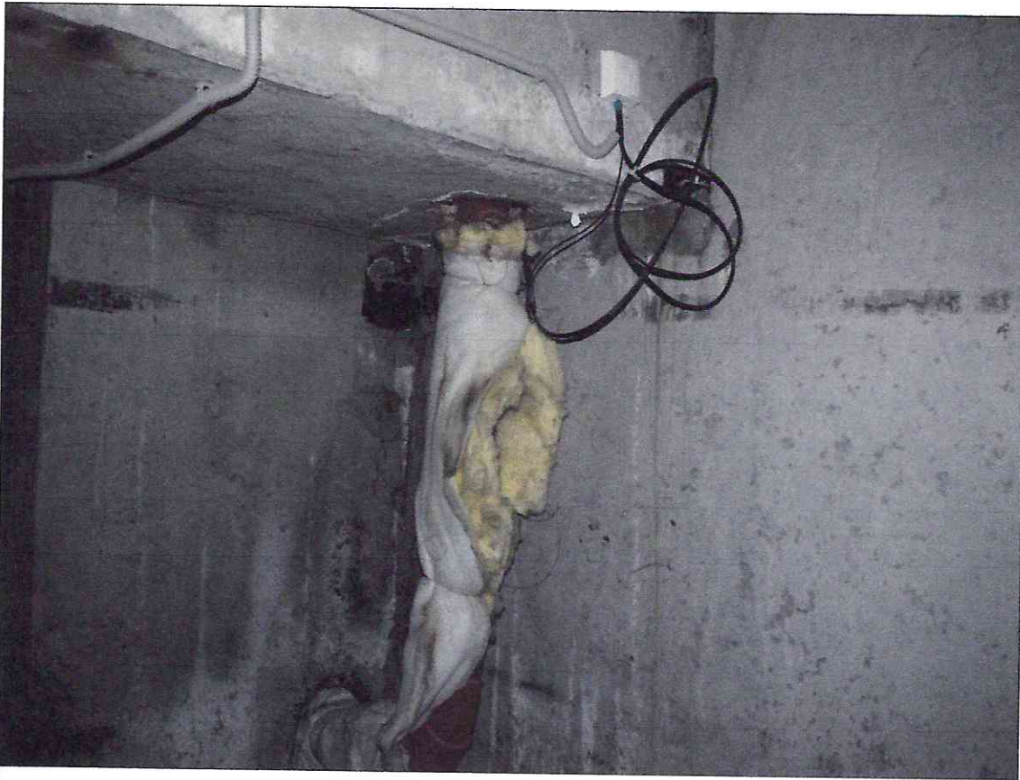
Рис. 23 Секция .С.5 Нарушение теплоизоляции водостока
