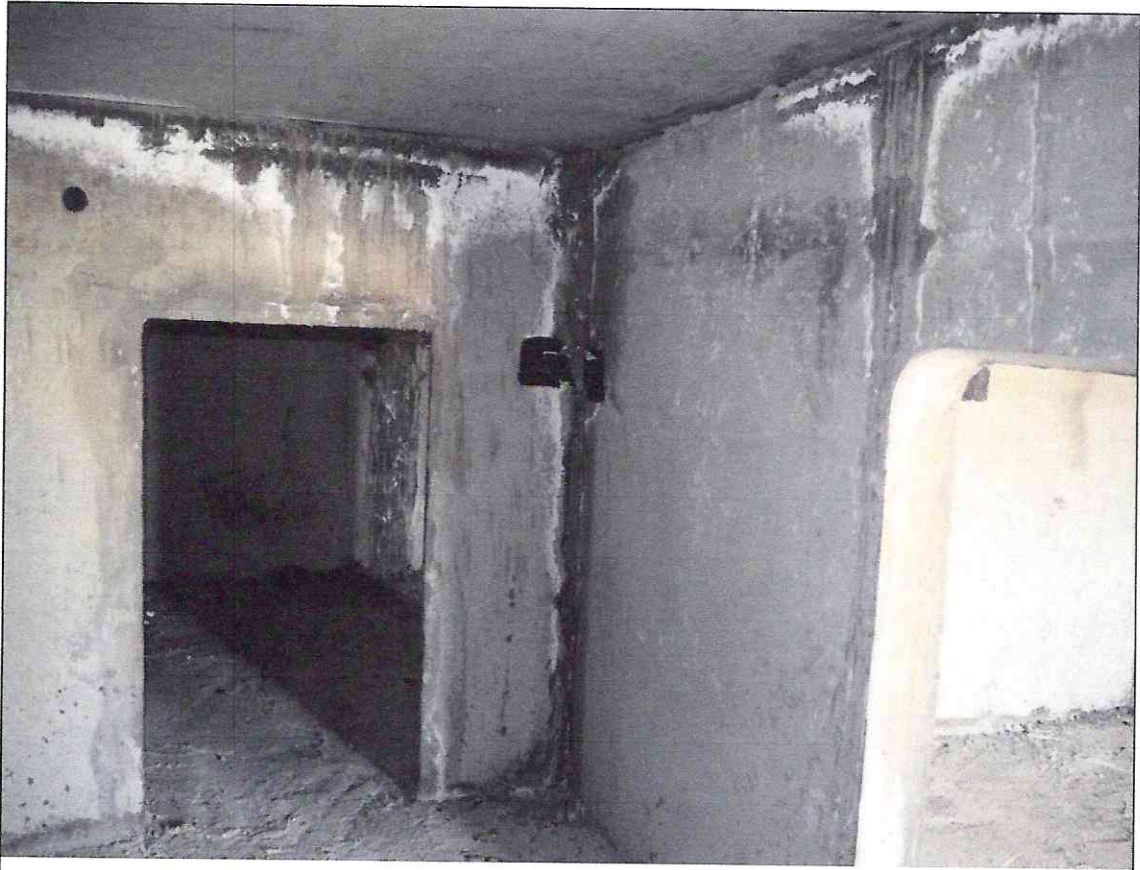
Рис. 25 Секция .С.4 Протечка кровли
