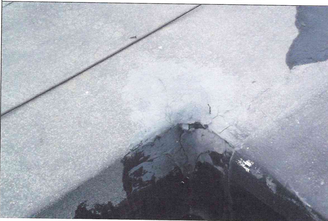
Рис. 14 С.4 Разрушение гидроизоляционного слоя. Состояние кровельного покрытия находится в удовлетворительном состоянии, имеются многочисленные трещины, отслоения, структура покрытия хрупкая.
