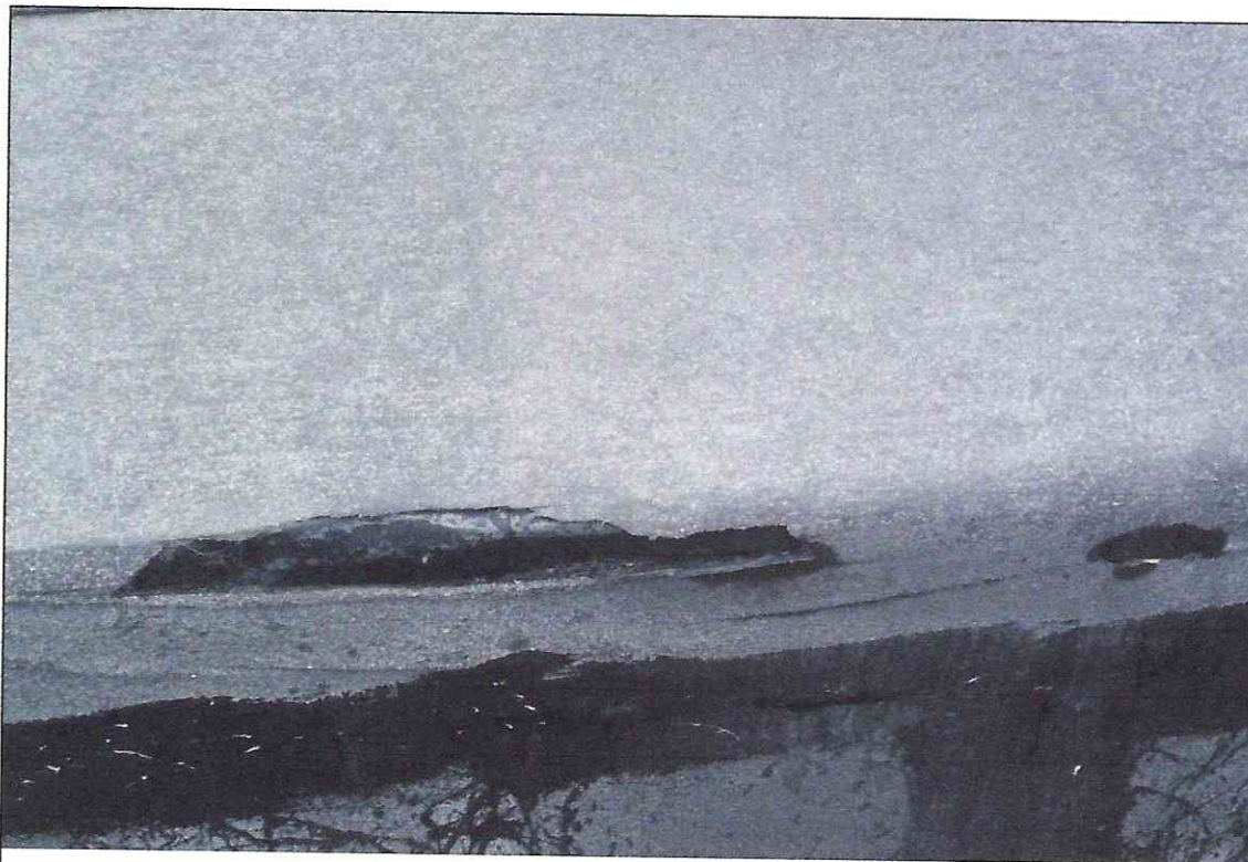
Рис. 13 С.4 Разрушение гидроизоляционного слоя. Состояние кровельного покрытия находится в удовлетворительном состоянии, имеются многочисленные трещины, отслоения, структура покрытия хрупкая.
