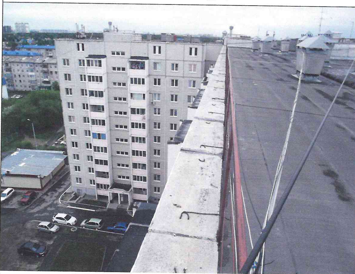
Рис. 18 Секция .С.3- С.5 отсутствует зачеканка швов парапетных плит
