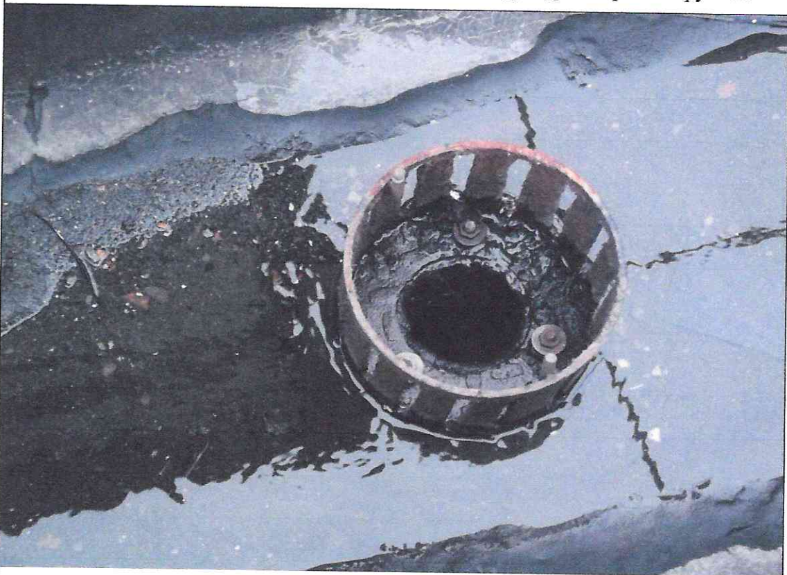
Рис. 20 Секция .С.1 Отсутствует крышка водосточной воронки
