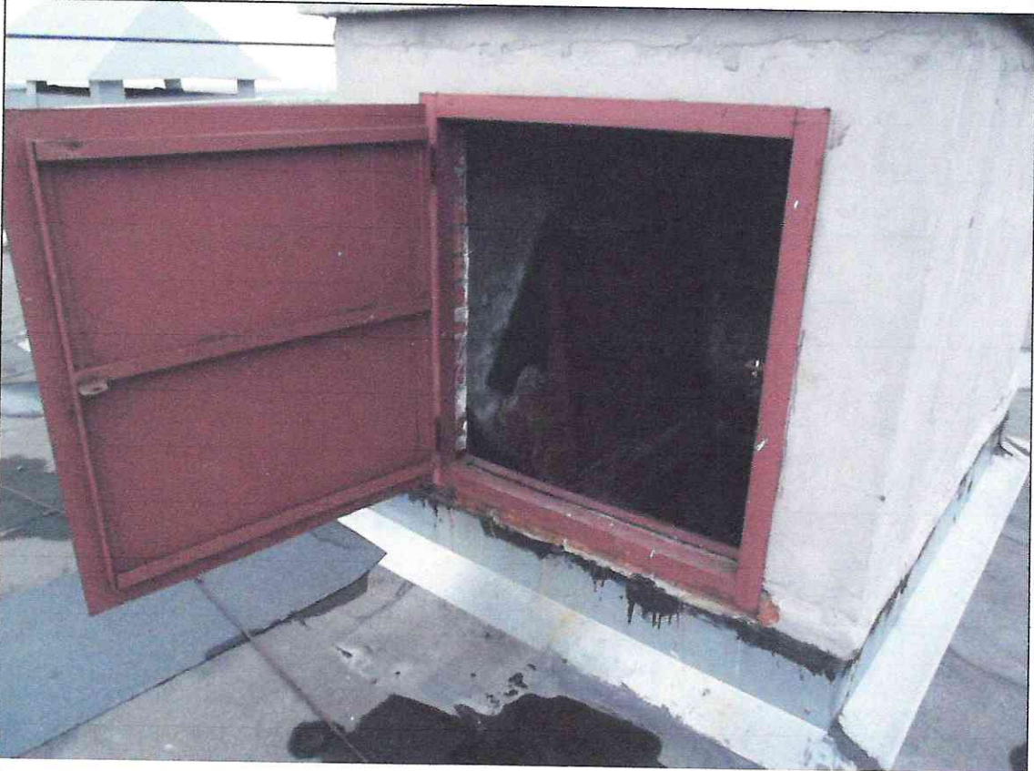
Рис. 16 С.1 Высолы на стенах выхода на кровлю
