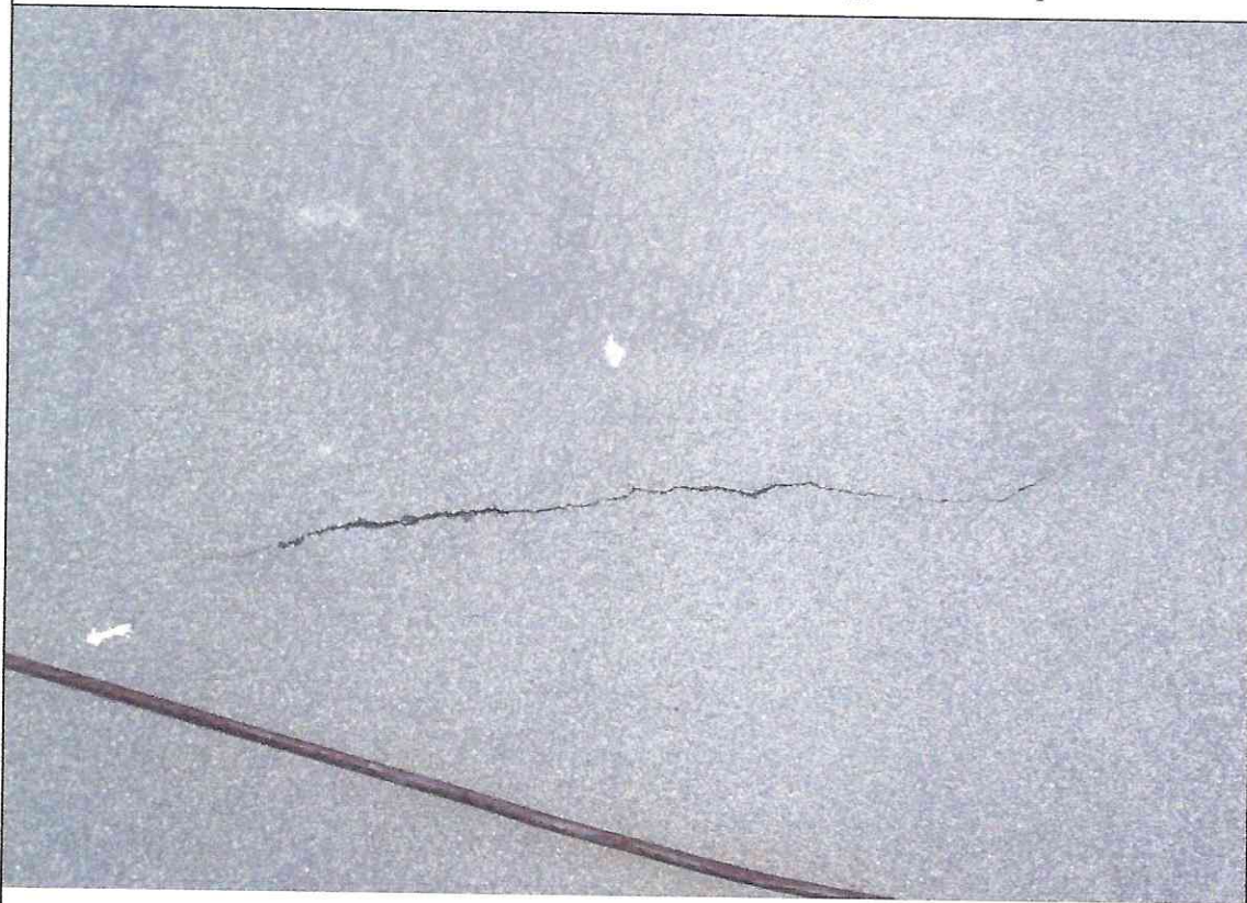
Рис. 10 С.3 Разрушение гидроизоляционного слоя. Состояние кровельного покрытия находится в удовлетворительном состоянии, имеются многочисленные трещины, отслоения, структура покрытия хрупкая.
