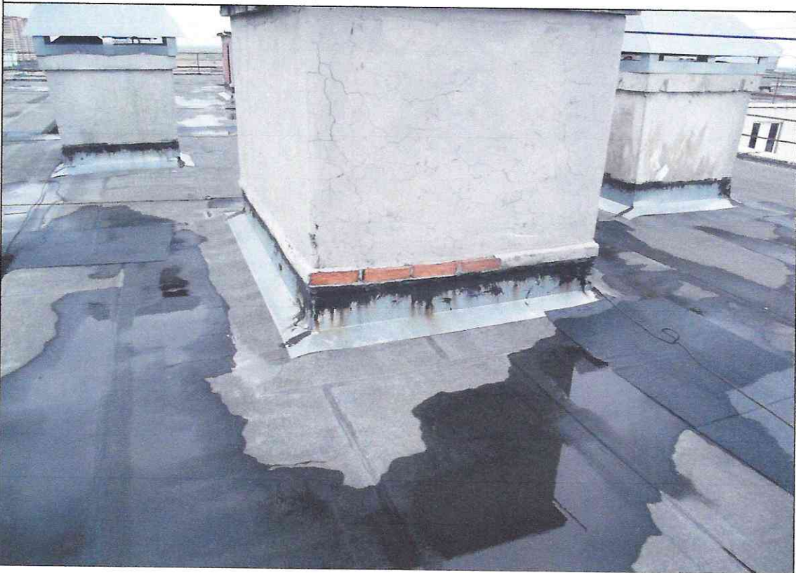
Рис. 6 Секция .С.1 Разрушение штукатурки конструкций из кирпича
