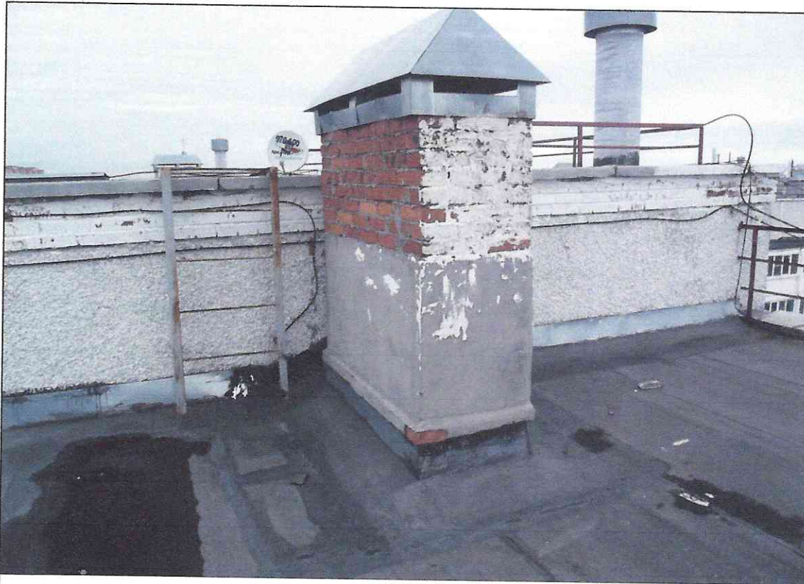
Рис. 7 Секция .С.1 Разрушение и отсутствие штукатурки конструкций из кирпича
