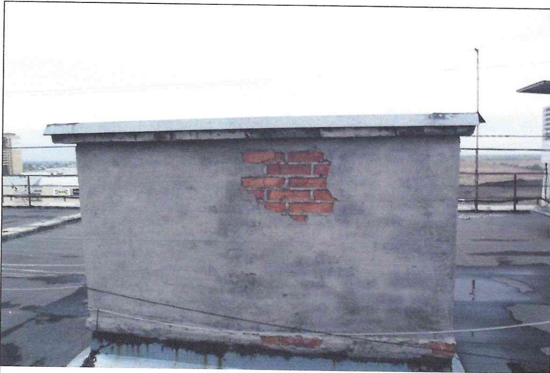
Рис. 9 С.3 Разрушение штукатурки конструкций из кирпича
