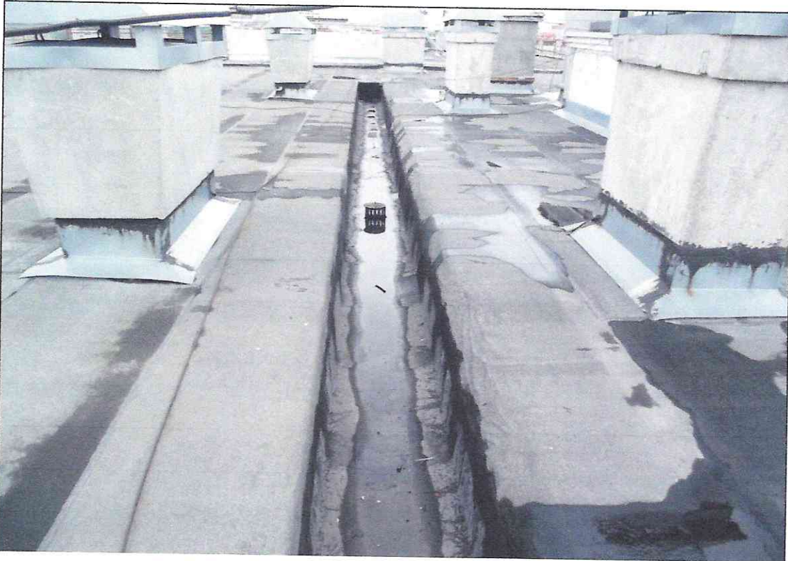
Рис. 19 Общий вид кровли, недостаточный уклон в водосточном лотке. Состояние кровельного покрытия находится в удовлетворительном состоянии, имеются многочисленные трещины, отслоения, структура покрытия хрупкая.
