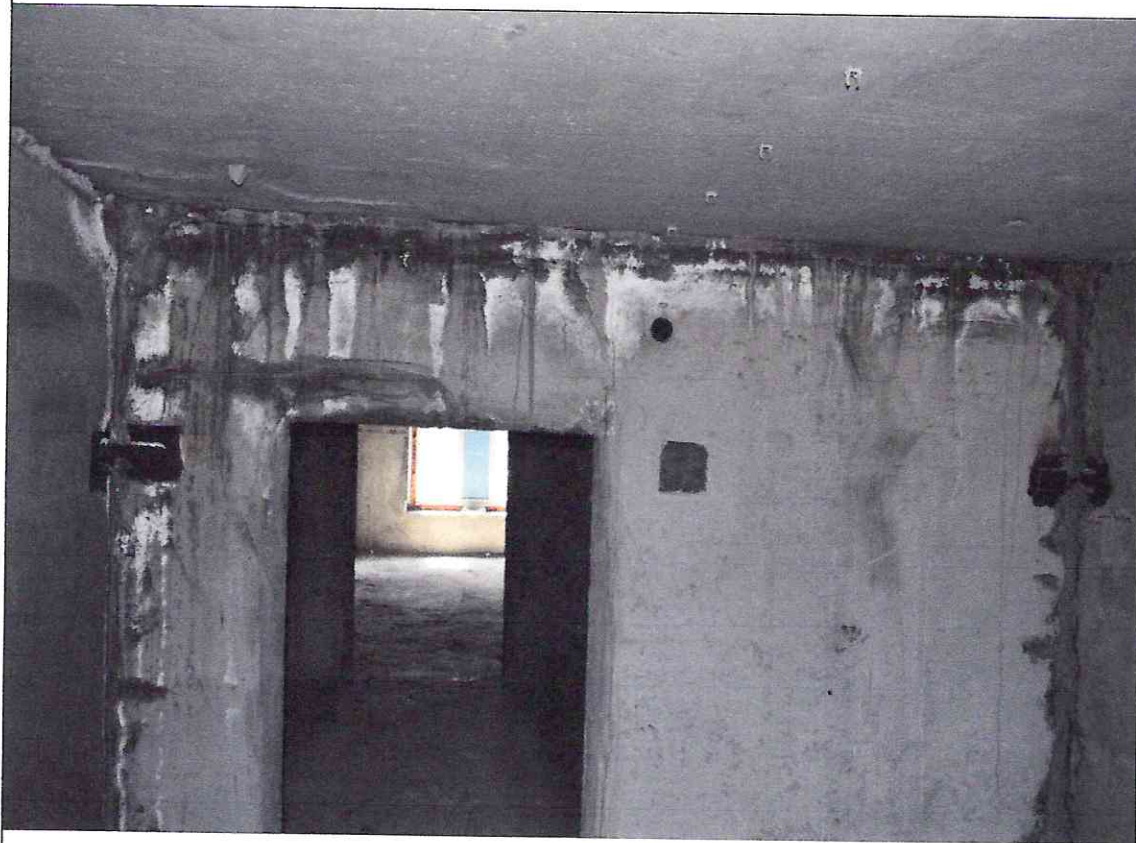
Рис. 24 Секция .С.4 Протечка кровли
