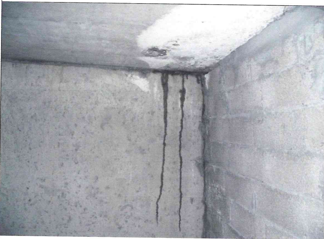
Рис. 8 Секция .С.2 Протечка кровли в районе элемента блокировки секций.С.1-.С.2
