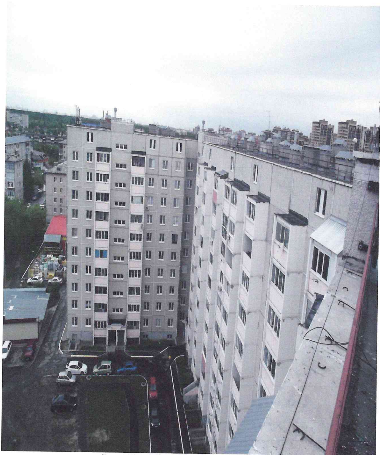
Рис. 2 Общий вид здания со стороны дворовой части
