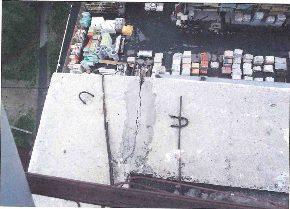
Рис. 5 Секция .С.1 отсутствует зачеканка швов парапетных плит
